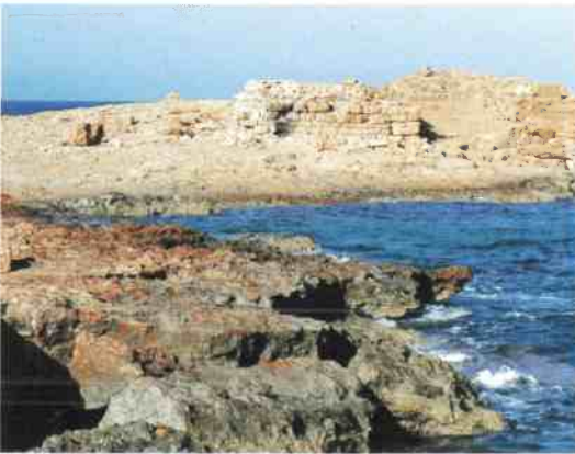
Fig. 15 Resti di un faro o di una struttura di servizio al porto. Phykous.
